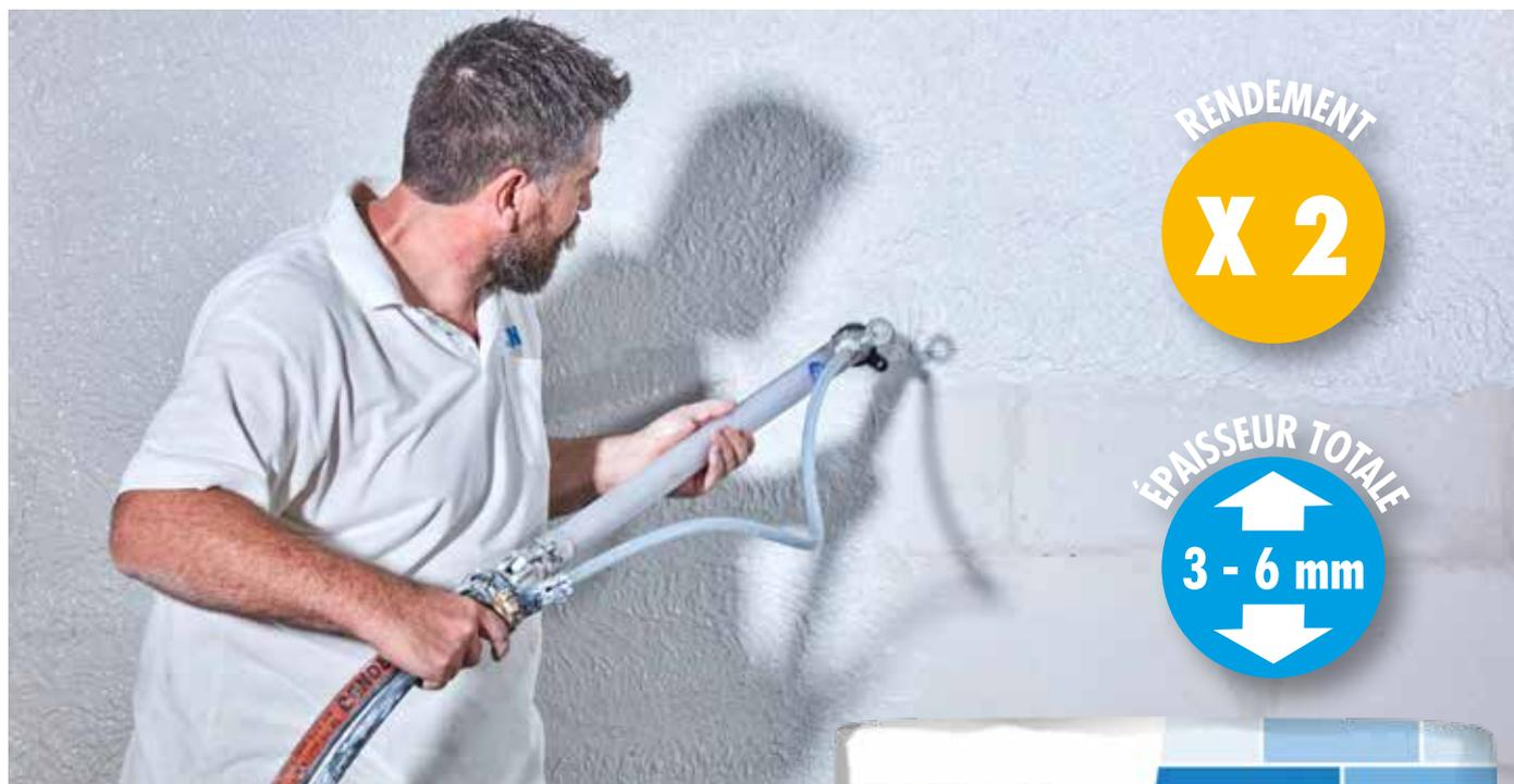
Silko 36 est un enduit de plâtre prémélangé en usine. Il convient comme enduit de parachèvement mince (de 3 à 6 mm) et est projetable à la machine sur des parois et plafonds intérieurs comportant un degré de planéité élevé (éléments en silico-calcaire, en béton cellulaire (CVI), blocs de plâtre, béton, parois préfabriquées en terre cuite, etc.).
